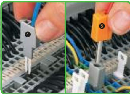
❹ Ficha de teste encaixada com CAGE CLAMP®
