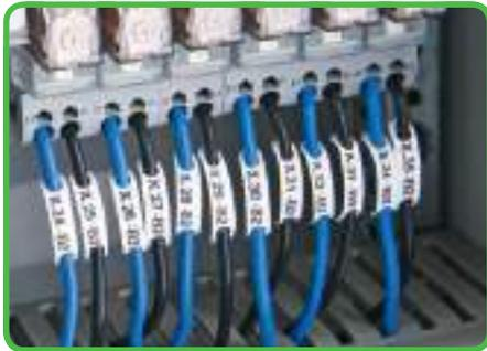
Marcação de Condutores para Montagem por Encaixe
