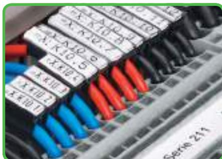
Identificação de condutor utilizando mangas de identificação.
