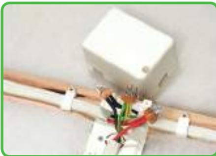
Conectores PUSH WIRE® utilizados numa caixa de distribuição. (Austrália)
