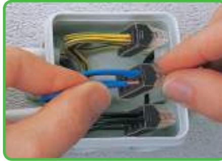
Conexão: Insira o condutor rígido totalmente descarnado!
