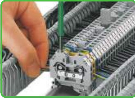
Abra a unidade de fixação utilizando uma chave de fendas e insira o condutor descarnado até atingir o batente.
