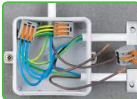
Instalação eléctrica dos condutores flexíveis numa caixa de distribuição.
