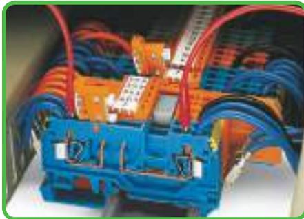
Desconectar com desconexão por faca. Ranhura de teste para fichas de teste de Ø 2 mm ou 2,3 mm - contacto directo com a barra de corrente.
