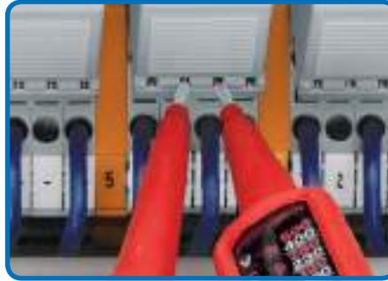
Ensaio de funcionamento através das ranhuras de teste à prova de toque
