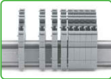
Encaixe, um a um, os bornes base na calha de suporte e agrupe-os.
