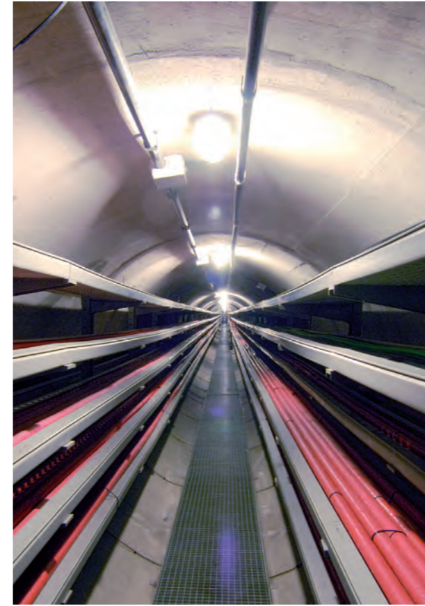
Aeroporto: galeria técnica
