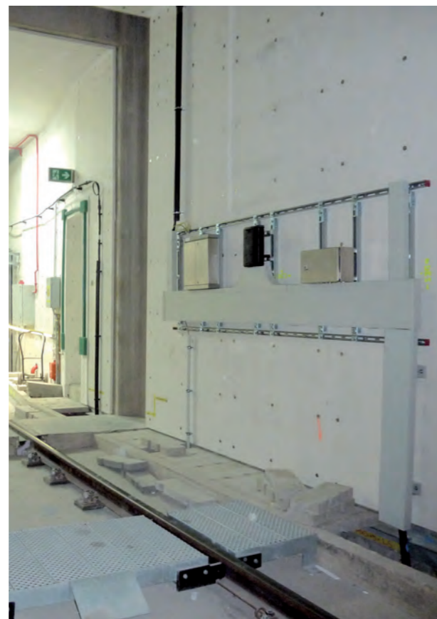
Infraestrutura ferroviária: túnel
