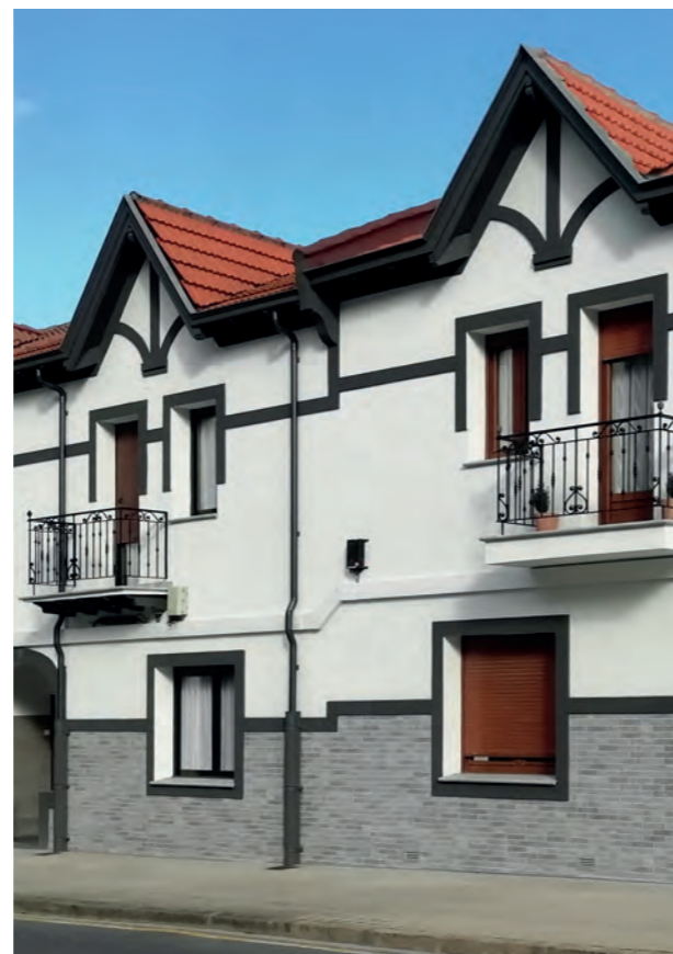
Habitação: distribuição pela fachada
